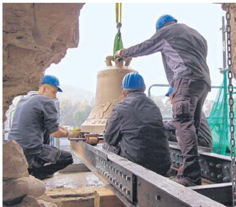
Behutsam werden die Glocken oben im offenen Turm entgegen genommen, auf Rollen gesetzt und innen an Flaschenzügen gesichert. FOTO: JÜRGEN LEONHARDT
