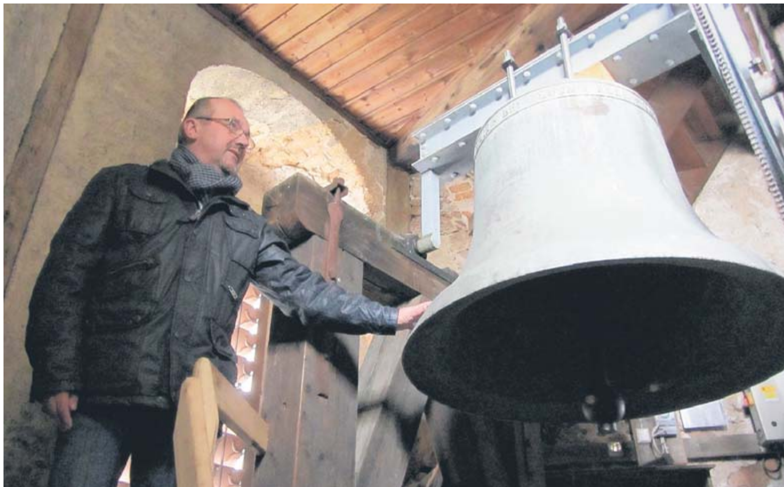
Für die neuen Glocken aus Bronze muss auch der Glockenturm umgebaut werden. Auch die Eisenjoche (Aufhängung) werden verschwinden. Pfarrer Rolf Scholz zeigt im Glockenturm von St. Georgen das bislang aktive Eisenhartgussgeläut.
